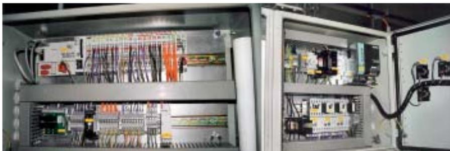
Die Schaltschränke sind unterteilt in einen Leistungsteil (rechts) und einen Steuerungsteil (links), in dem das kompakte Steuerungssystem nur wenig Platz benötigt
